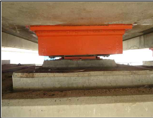
교량받침 상태 양호
