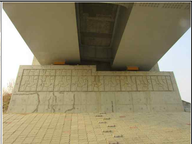
교대 A2 전경(상태양호)
