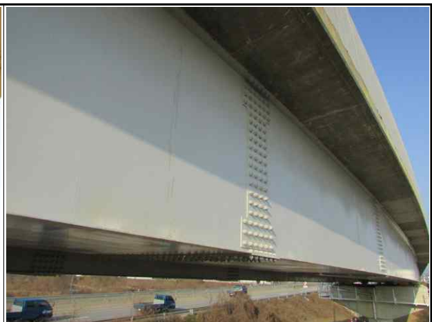
강재 거더 상태양호
