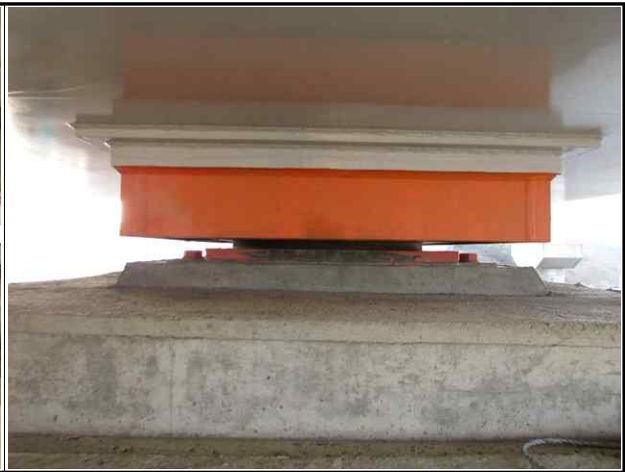
교량받침 상태 양호
