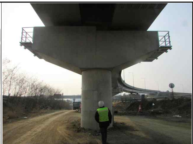
교각 P7 전경(상태양호)
