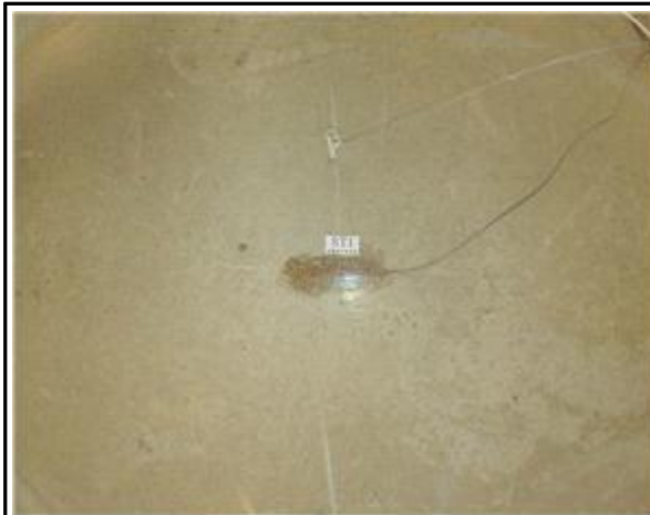
변형률계 설치 현황
