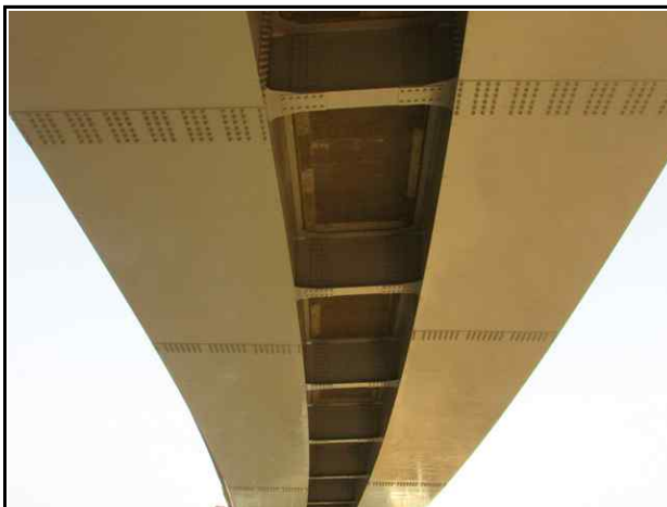
강재 거더 상태양호
