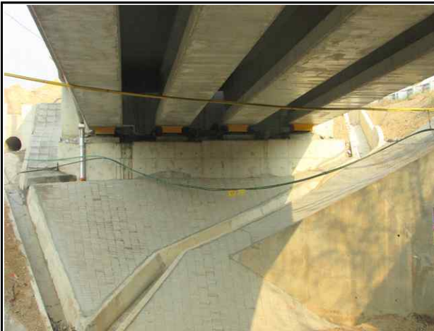
교대 A1 전경(상태양호)
