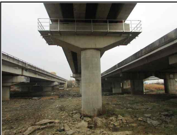
교각 P3 전경(상태양호)
