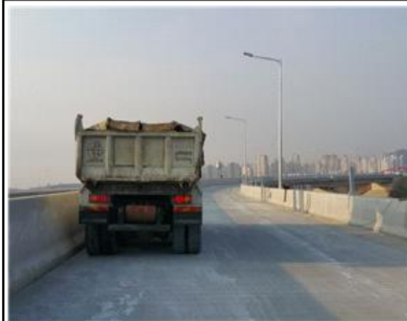
정적 재하시험 전경
