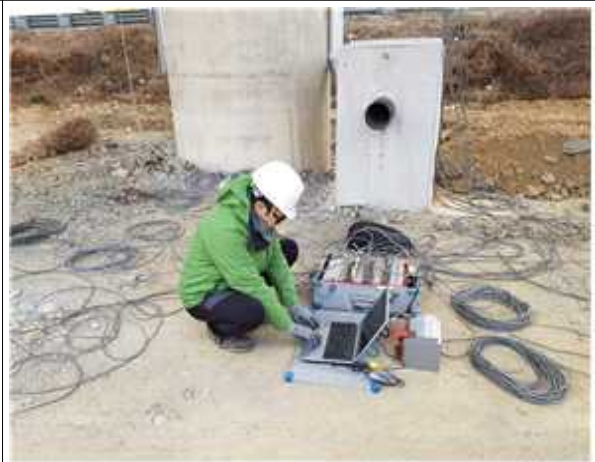
재하시험 계측 전경
